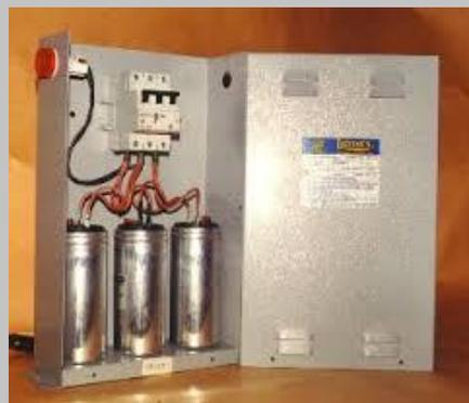
*Corrección Fija, para cargas individuales como motores y/o máquinas.-*
